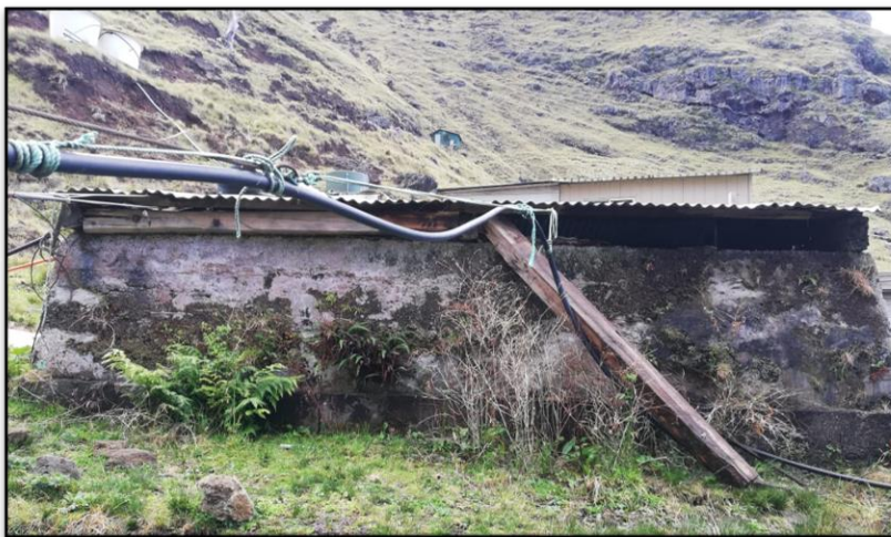
Figura N° 10: Otra perspectiva del estanque de cemento.
