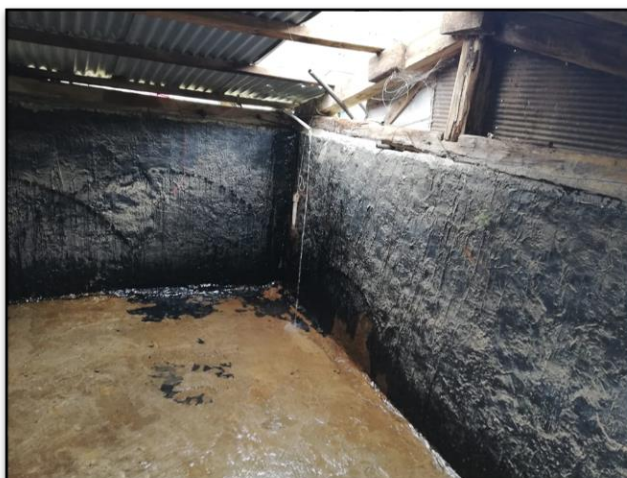
Figura N° 11: Interior estanque de cemento.
