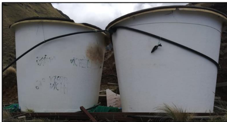
Figura N° 12: Estanques de polietileno.
