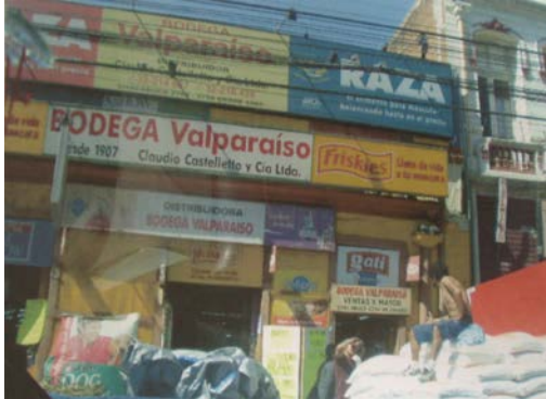
Fachada con extrema contaminación visual
