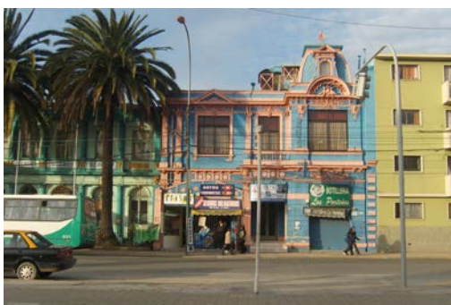
Edificio de alta calidad arquitectónica en sus fachadas, se desvaloriza por colorido inadecuado
