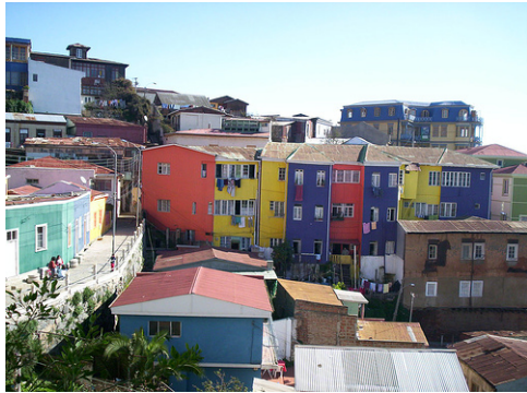
13 familias habitan estos dos edificios hermoseados en el proyecto
