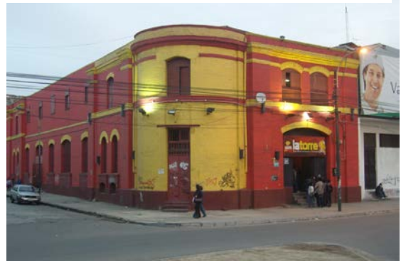
Fachada que irrumpe luminicamente, desequilibra la armonía de su entorno.
