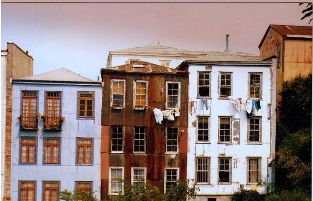
Imagen n° 26. Fachadas de Valparaíso compuestas de lata y dispuestas en base a la verticalidad.
