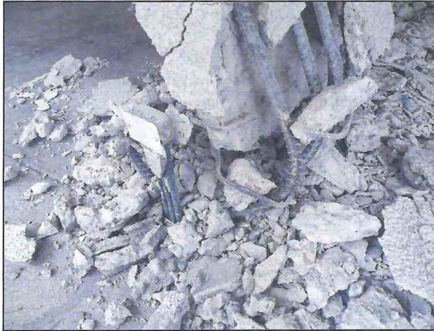
Figura 1.10 Detalle muro M5 [11].
