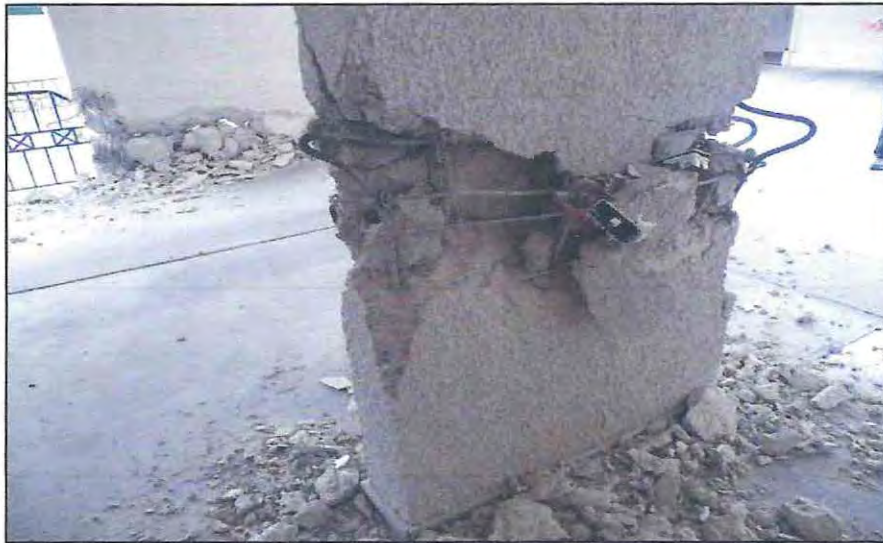
Figura 1.9 Vista muro M3 [12].
