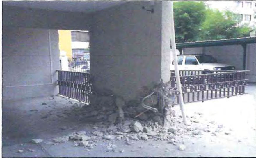
Figura 1.8 Vista muro M1 [12].
