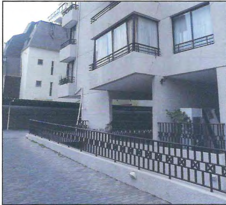
Figura 1-1 Vista fachada poniente diagonal [12].
