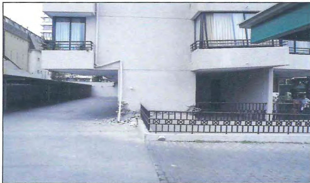
Figura 1.15 Vista panorámica de muros fachada poniente [11].
