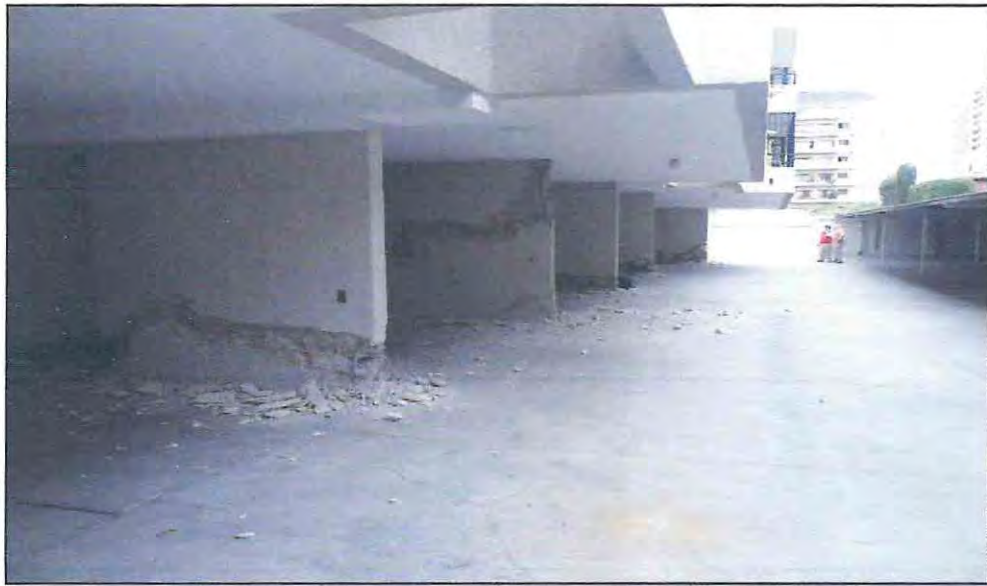
Figura 1.14 Vista panorámica de muros primer piso [11].
