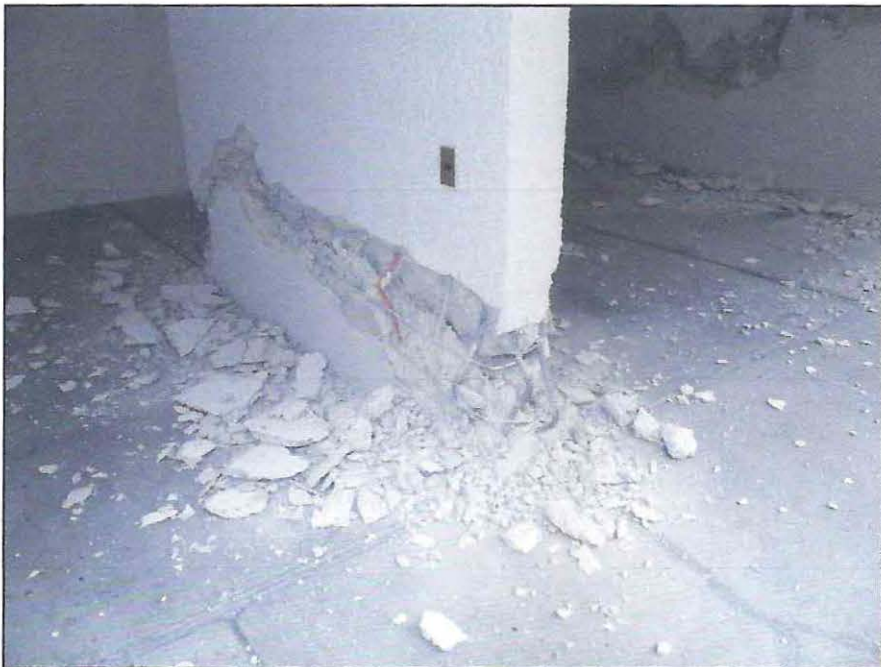
Figura 1.13 Vista muro M11 [11].
