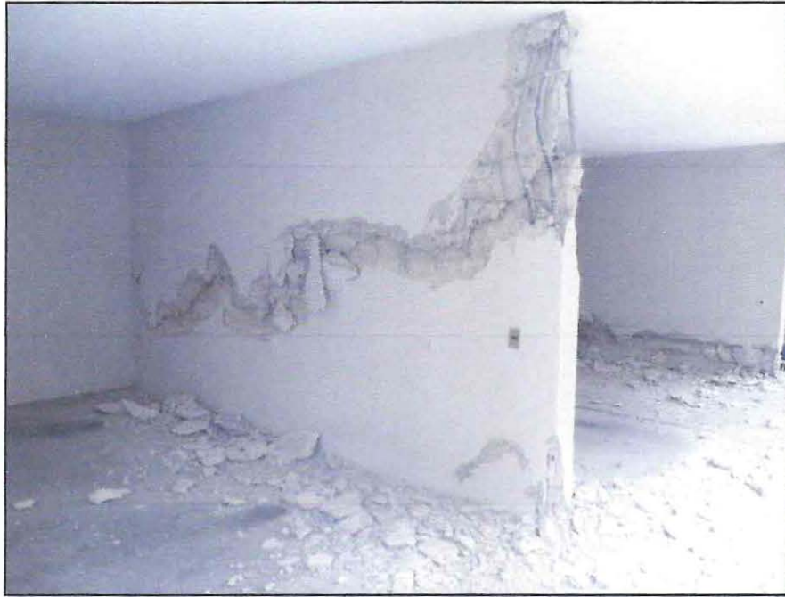
Figura 1.12 Vista muro M9 [11].
