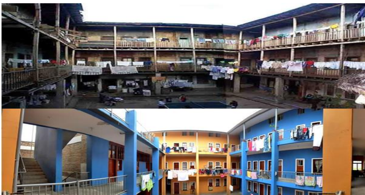
IMAGEN 7: Población Obrera: antes y después de la rehabilitación
