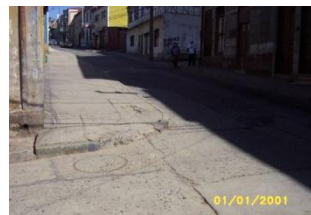
Imagen Nº20: Agrietamientos calle y aceras, calle Castillo. Fuente: Campos, F. Calderón, D. Jofré, P. Pino, M. Peña, J. Ruiz., 2004
