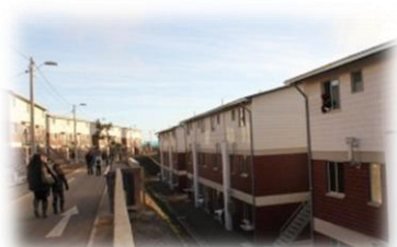
Conjunto Habitacional Baquedano, Llo-Ileo, San Antonio. 2012
