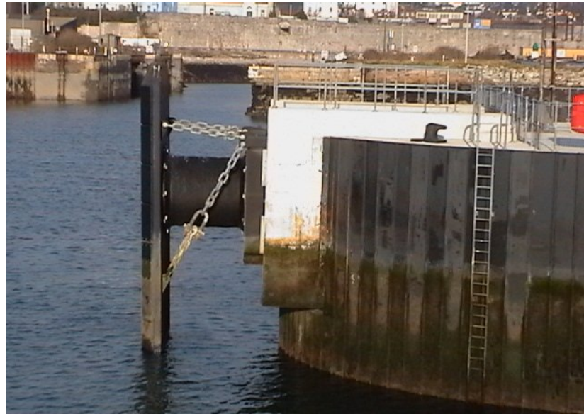
Figura 8-5: Sistema de Defensa Cell Fenders, Bridgestone [Fuente: Referencia 1].
