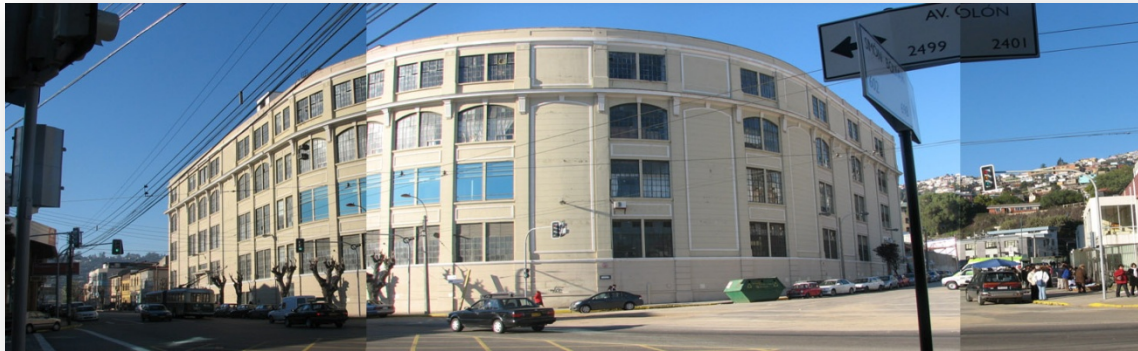
Imagen N°21: Fotografía Edificio ex Chiletabaco, año 2005, hoy en día demolido. Colón frente a Hospital Carlos
