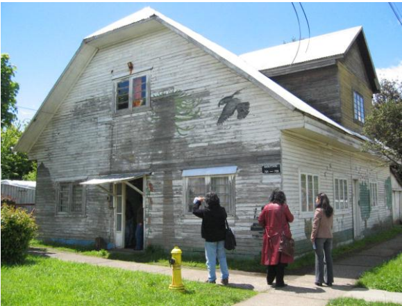
Estructura Fachada Casa Remolienda
