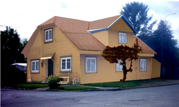
Fachada en construcción.
