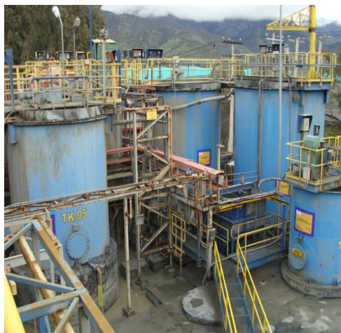
Figura 2 Estanque de Lixiviación
