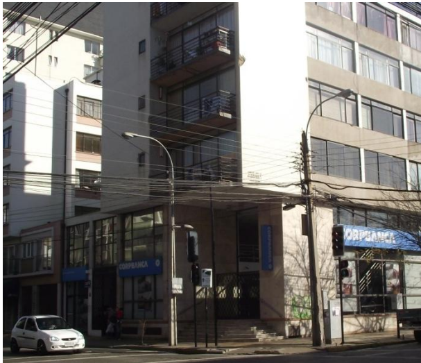
Detalle acceso principal 65
