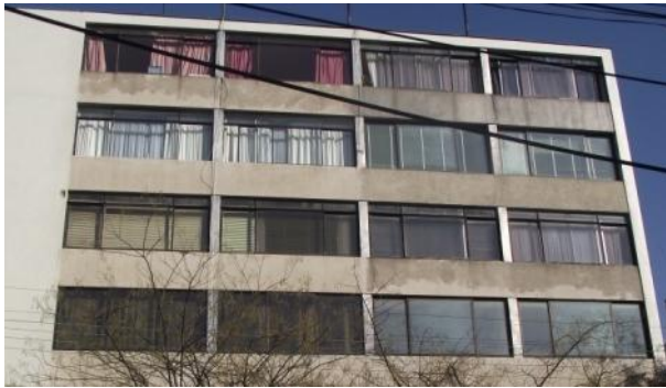
Imagen de la Fachada norte, con sus respectivas ventanas 62
