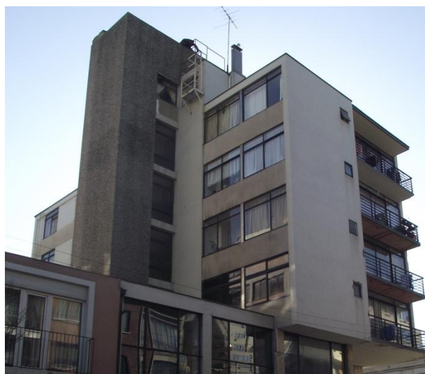
Paño vertical que acompaña la salida del volumen de escaleras 68
