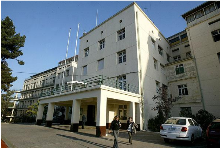
Ilustración 19: Fachada norte del Hospital Eduardo Pereira
