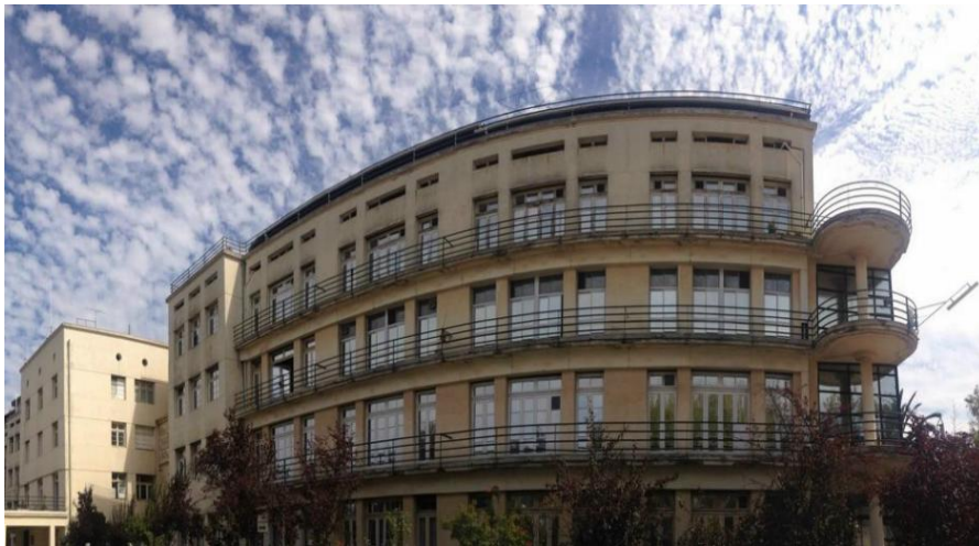
Ilustración 20: Fachada noroeste Hospital Eduardo Pereira
