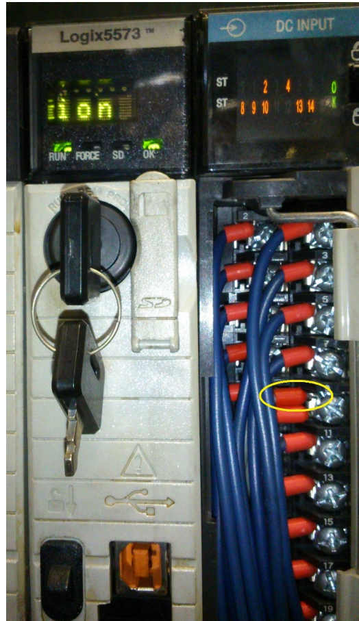
Figura 29: Instalación del cable del sensor al PLC.
