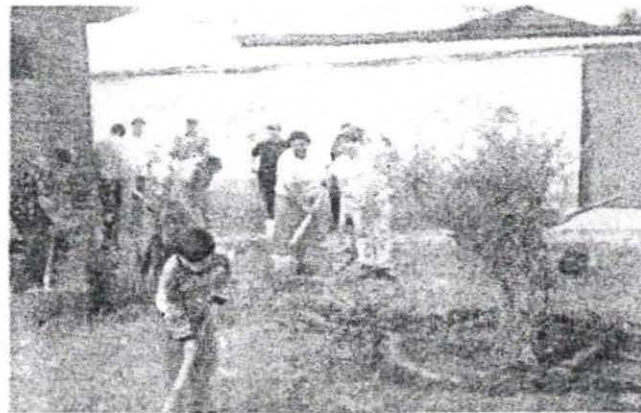
3. Limpieza del terreno de la sede comunitaria.
