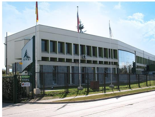
Ilustración 1: Fachada de Laboratorios KNOP. Fuente: KnopLabs.
