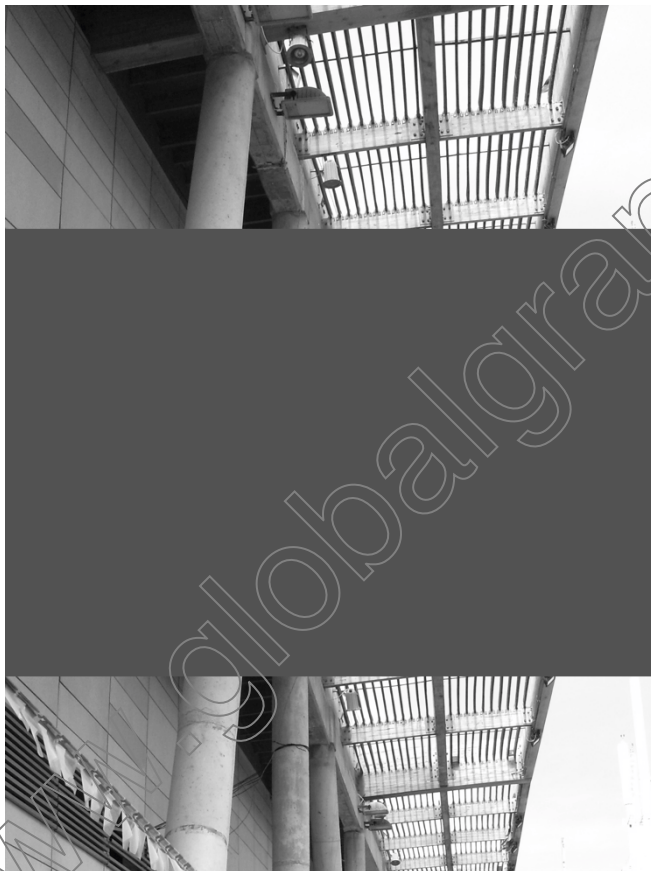
Ejemplo de estructura en base a pilares de H.A. que han sido inclinados. Caleta Portales.
