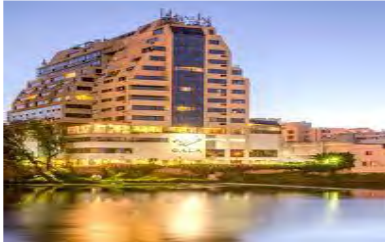
Figura 10: Vista edificio Gala Hotel
