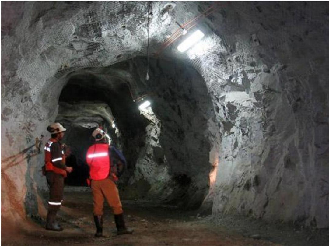
3.- Vista de mina subterránea fortificada con malla de acero y shotcrete.
