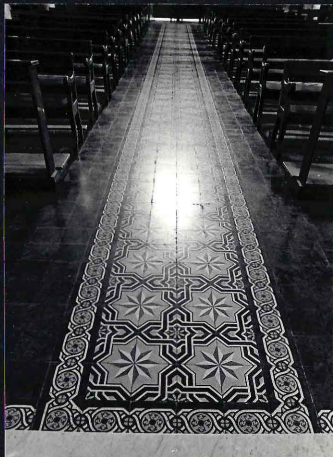
Foto 39.- Piso de baldosa que cubre el primitivo pavimento de ladrillo.
