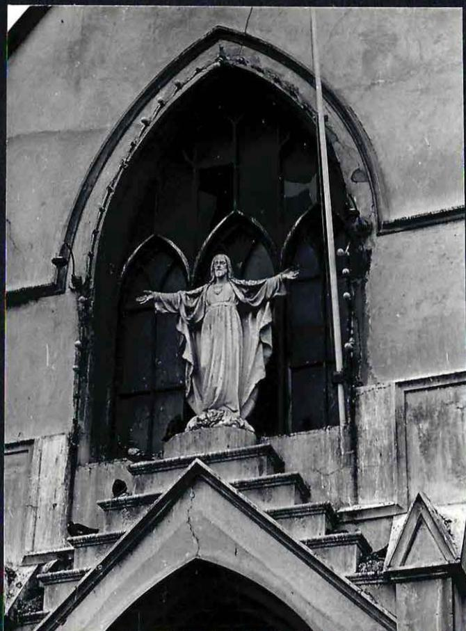
Foto 8.- Ventanal mayor en el frontis; tracería de madera; Sagrado Corazón sobre el pedestal escalonado incorporado posteriormente en la construcción.
