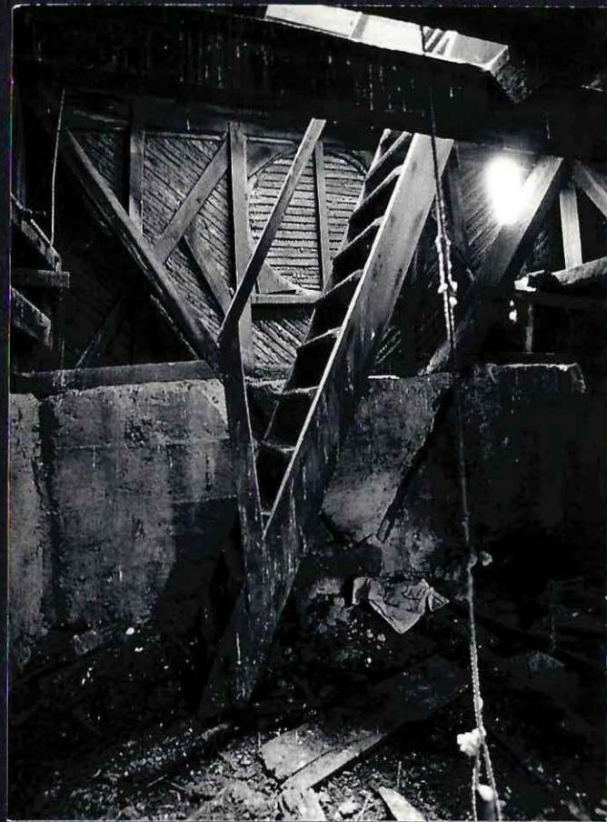
Fotos 40 y 41.- Interior de la torre, en su tercer nivel. Se aprecia estructura de madera con envigado diagonal según cruz de San Andrés; el material liviano que se usó en su parte superior y algunos vanos tapiados.
