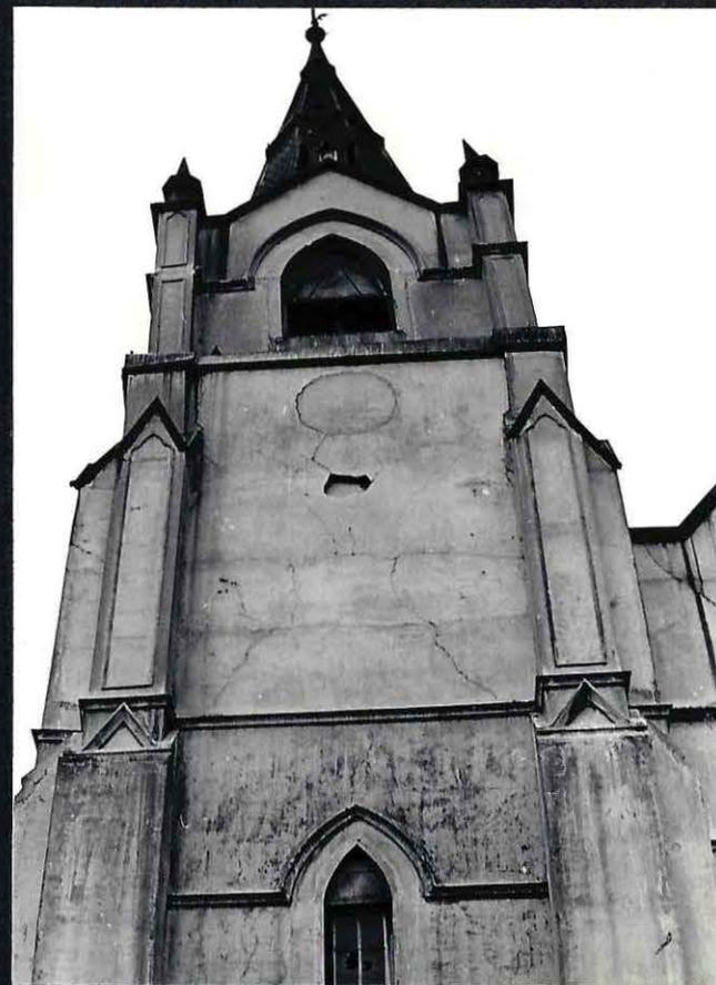
Foto 11.- Torre en la iglesia inclinada hacia el Norte; en algunas agrietaduras se aprecia el cambio del muro macizo por material liviano.
