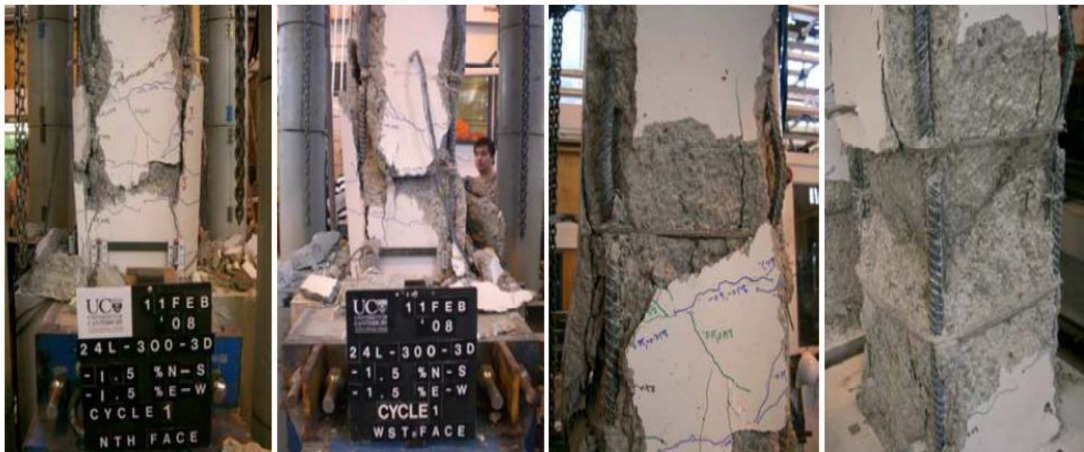
Figura 5.1 – Daño en columnas con 1.5% Drift y P=0.3 f'_c A_g Fuente: [16]
