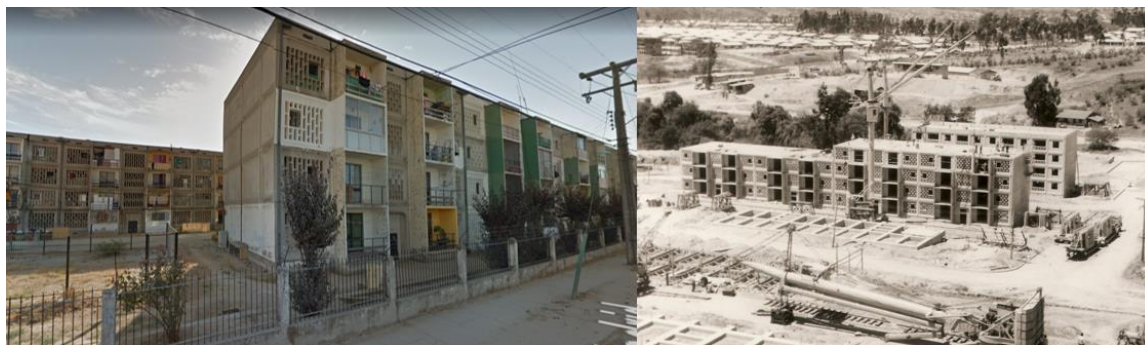
Figura 2.1. Derecha: Construcción del Conjunto Habitacional KPD en el Belloto. Izquierda: Conjunto Habitacional KPD en el Belloto en la actualidad. [15]
