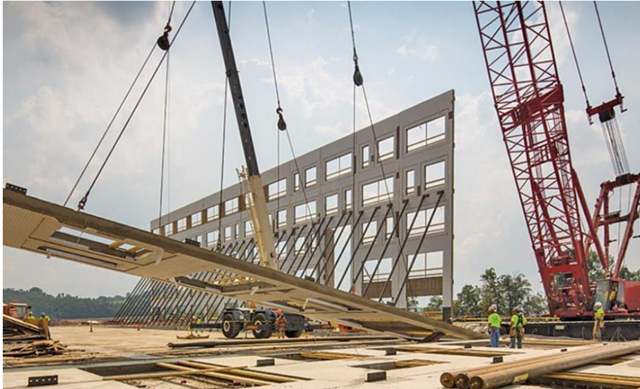
Figura 2.3. Ejemplo de construcción tilt-up.
