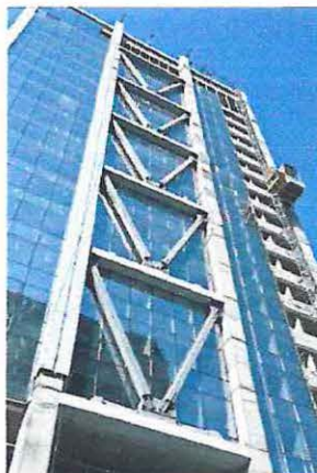
Figura 2.7 Sistema disipación para Proyecto Las Condes Capital [10].
