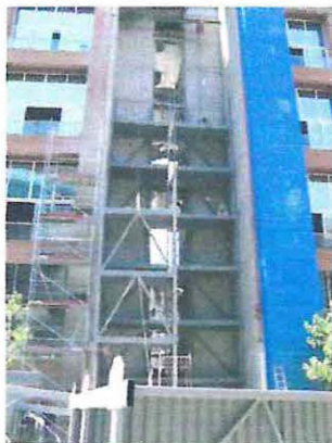
Figura 2.6 Reforzamiento con amortiguadores de tipo viscoso [6].
