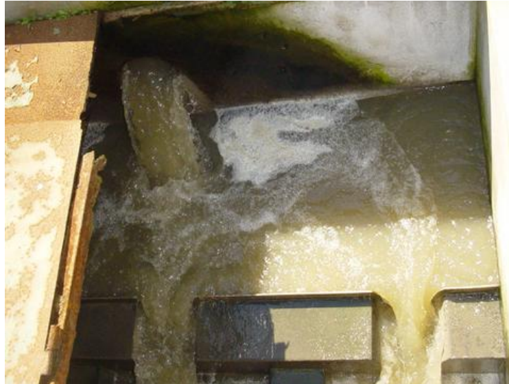
Figura 8. Fotografía de la Cámara Divisora de 3 vías.
