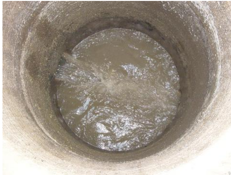
Figura 7. Fotografía en vista superior del Desarenador.
