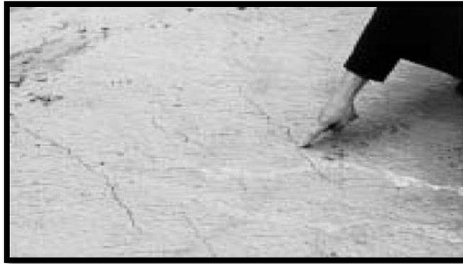
**Figura N°2.1: Fisuras por retracción plástica en losa de hormigón**
