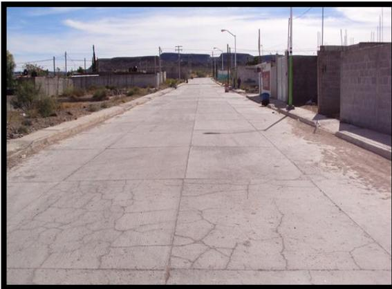
**Figura 1.1: Fisura por retracción plástica**
