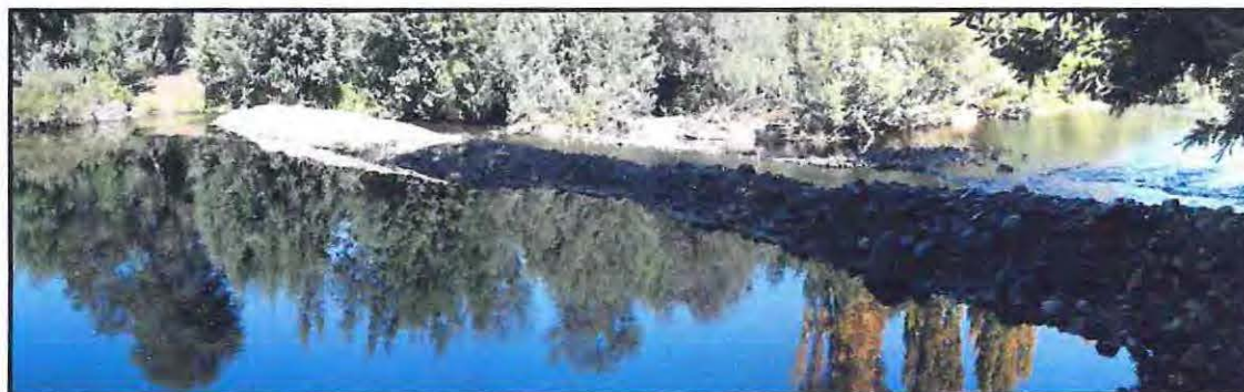
Figura 6.14- Barrera provisoria captación Río Malleco Collipulli. Fuente: Proyecto, Diseño mejoramiento sistema de producción de agua potable de Collipulli, elaborado por S&E consultores.
