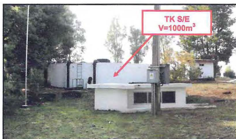
Figura 6.12- Estanque (TK) Santa Lucía semienterrado (S/E). Fuente: Proyecto, Diseño mejoramiento sistema de producción de agua potable de Collipulli, elaborado por S&E consultores.
