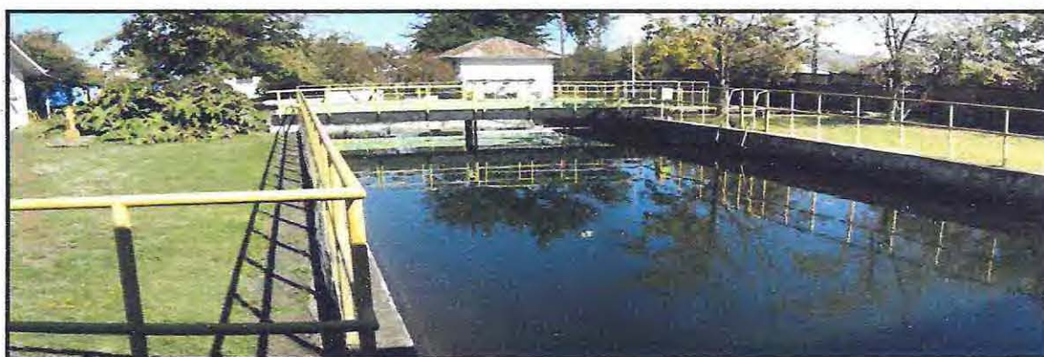
Figura 2.2-Sedimentador gravitacional, PTAP Collipulli. Fuente: Proyecto, Diseño mejoramiento sistema de producción de agua potable de Collipulli, elaborado por S&E consultores.
