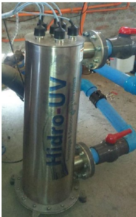
Ilustración 2.2.2.4.2: Equipo de desinfección agua filtro UV.
