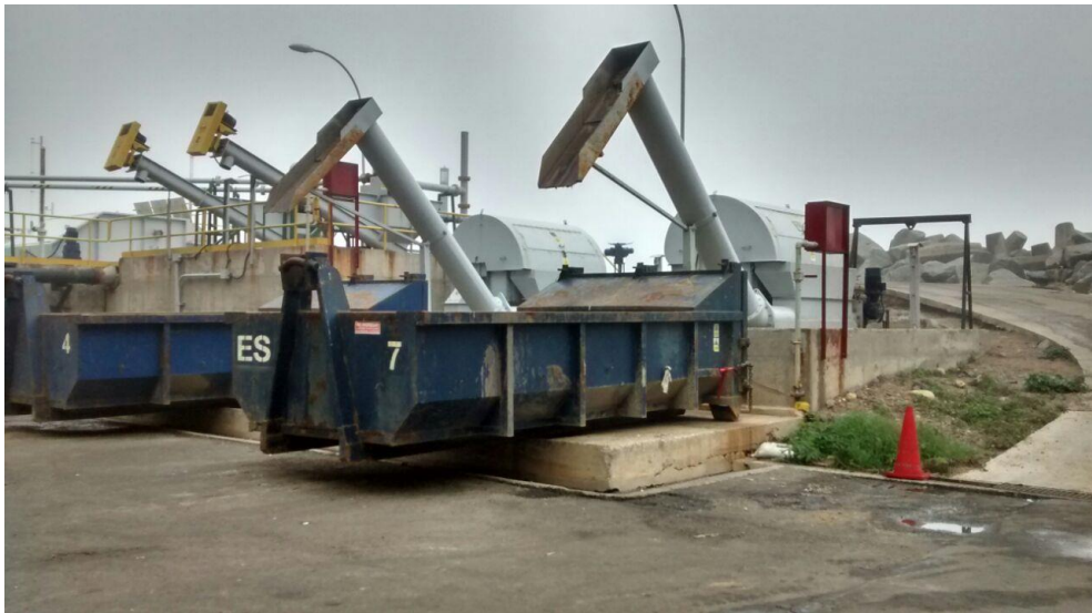
Contenedores Arena y Sólidos Reja Fina PTAS Loma Larga. Captura fotográfica Junio 2016
