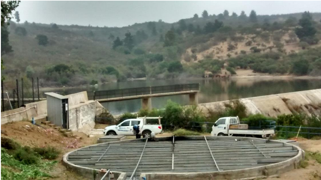
Proceso de Floculación PPAP Poza Azul. Captura Fotográfica Marzo 2016
