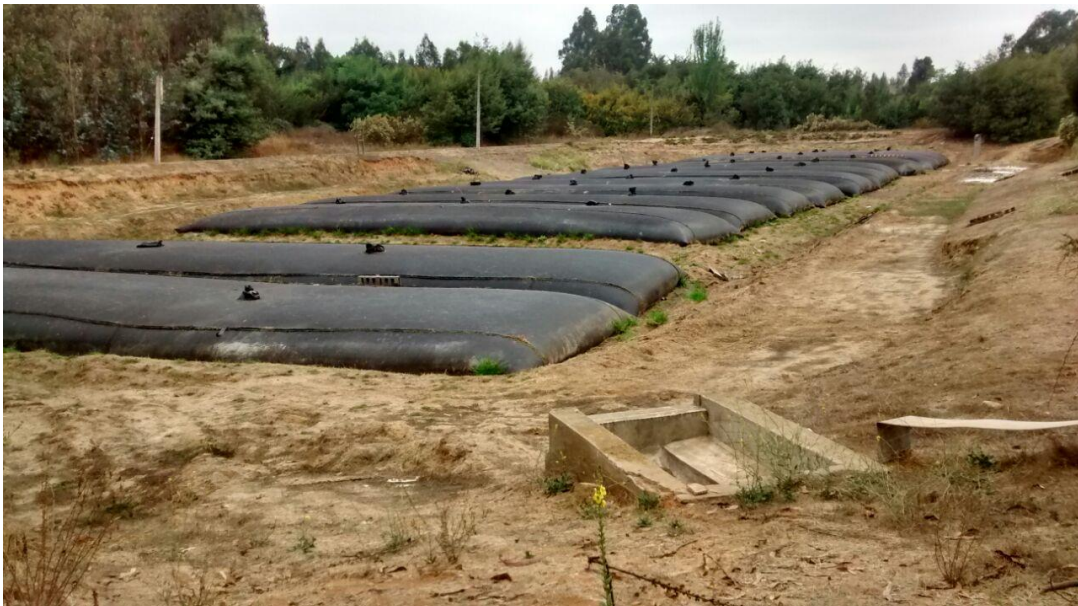
Depósito de Lodos Deshidratados PTAS (LA) Placilla. Captura Fotográfica Abril 2016
