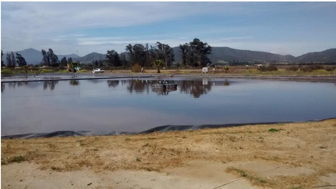
Laguna Sedimentación PTAS (LA) Casablanca. Captura fotográfica Octubre 2016
