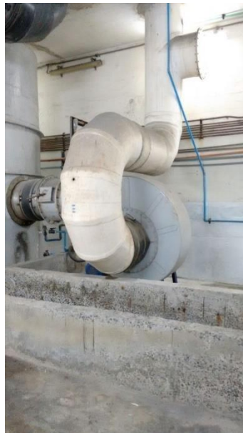
Salida de gases a Chimenea PTAS 2 Norte. Captura fotográfica Septiembre 2016
