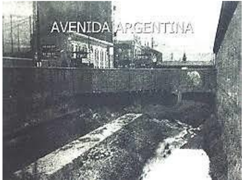
Trabajos de abovedamiento del Estero Las Delicias, actual Av. Argentina.
