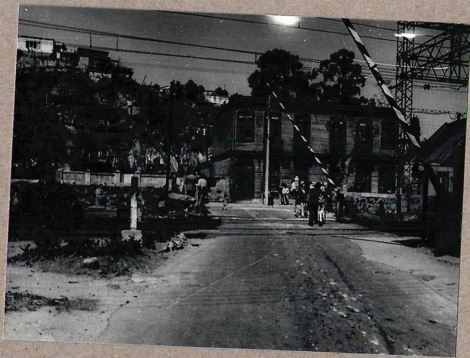
Cruce A nivel calle Montenegro
