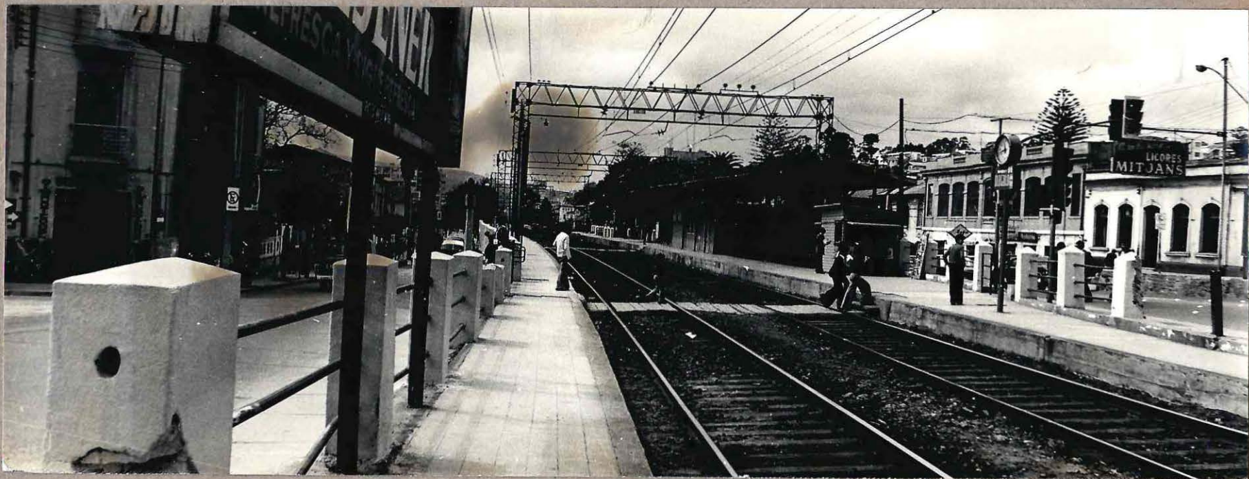
Cruce peatonal de Agua Santa
