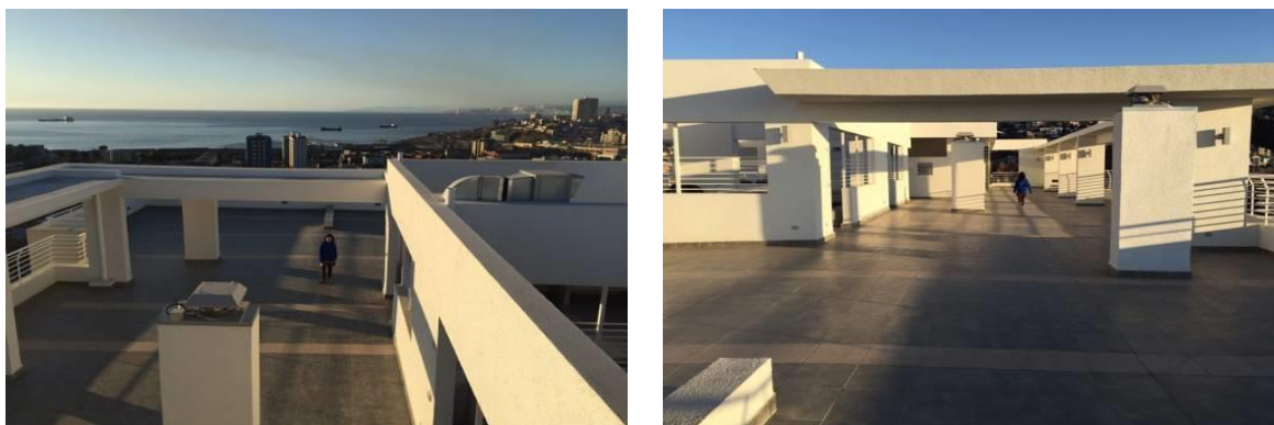
Figura 69 Área de azotea EEV 2.3. Fuente: http://checkinly.com/es/geopark-valparaiso,h.html#zoom-img-gallery[room151208501/0/
