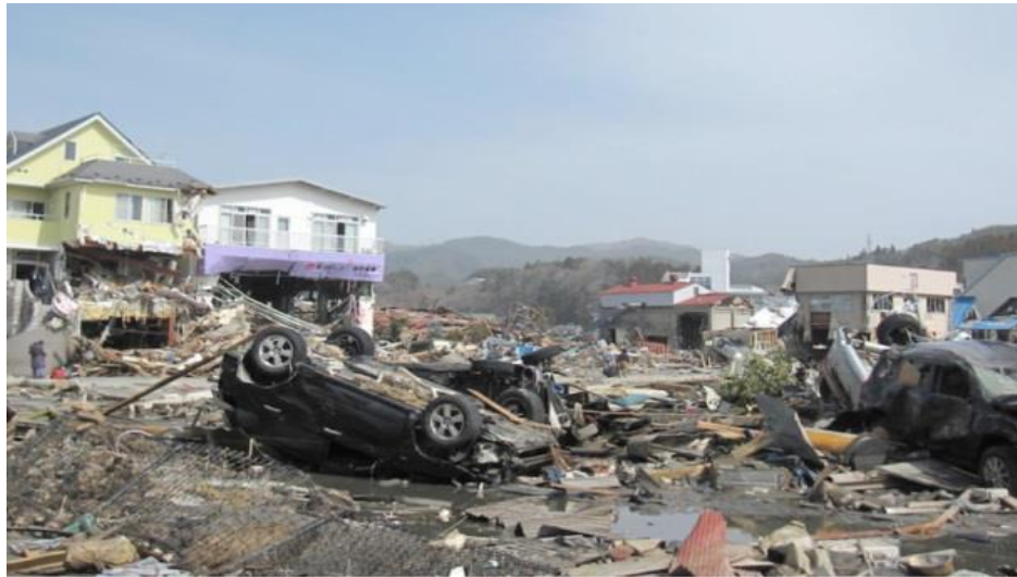
Figura 6 Daños a sectores residenciales, autos, camiones y escombros debido a la acción del tsunami en el sector de Kesennuma, Japón (Imamura & Anawat, 2012).
