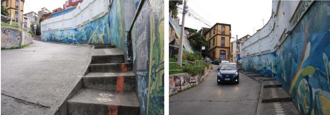
Figura 48 Estrechez y estado de la vía de evacuación horizontal, intersección calle Edwards con Av Colón en dirección sur. Elaboración propia.
