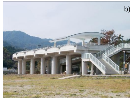
Figura 27 Refugios de concreto reforzado en Prefectura de Tokushima, Japón (FEMA, 2008).
