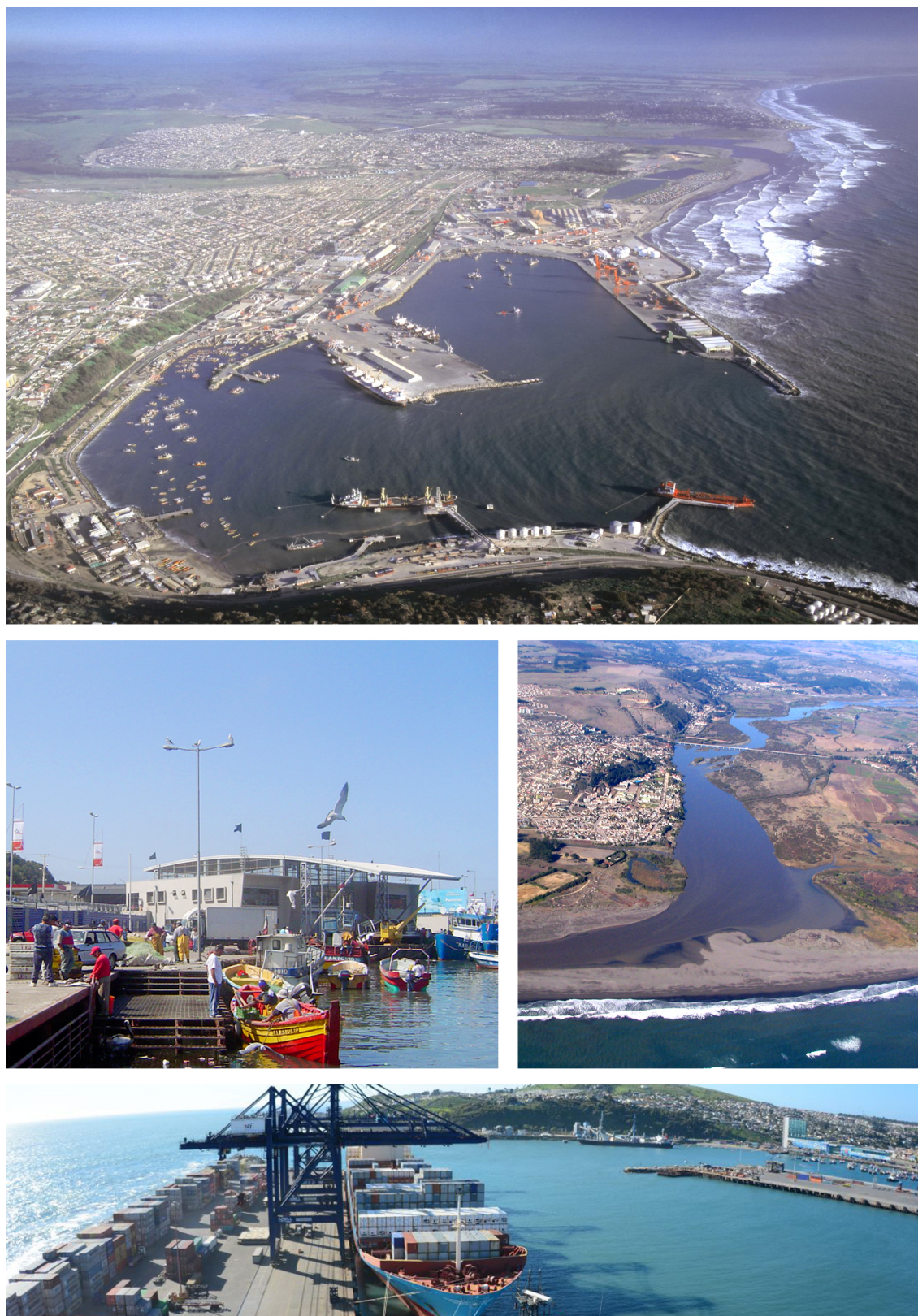
Figura 1.1.1: Arriba: Fotografía aérea del Puerto de San Antonio, tomada a principios del siglo XXI. Al centro se muestran la dársena exterior -que alberga terminales porta-contenedores, de graneles y de carga general- y la dársena interior donde se ubica el puerto pesquero de Puertecito. Hacia el sur aparecen sucesivamente la localidad de Llolleo, la desembocadura del río Maipo, la localidad de Santo Domingo y el Humedal del Yali. Centro: Muelle pesquero en Puertecito y desembocadura del río Maipo. Abajo: Porta-contenedores atendido por grúas Gantry en el molo sur.
