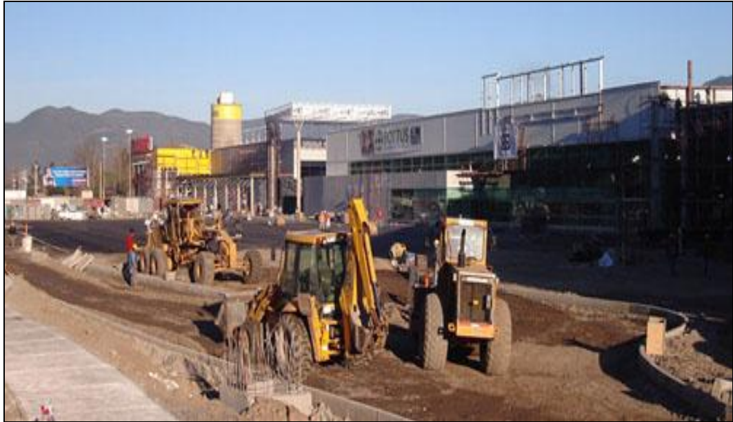
Imagen N° 4: Construcción centro comercial de La Calera.
