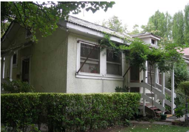
Casa 22 Revestimiento de estuco de hormigón.
