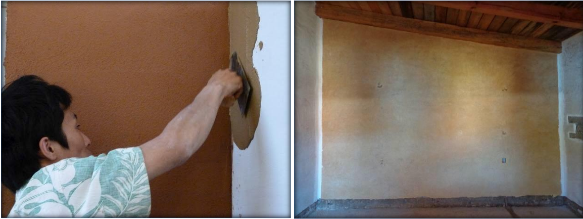
Figura 2.2: Revoque grueso (izquierda), revoque fino (derecha)
