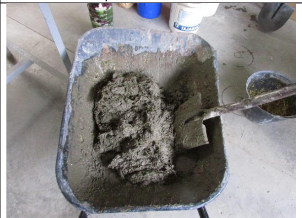
Integración de elementos en mezcla suelo-cal-fibra
