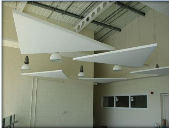
Figura 2.7: Cielo falso especial tipo isla
