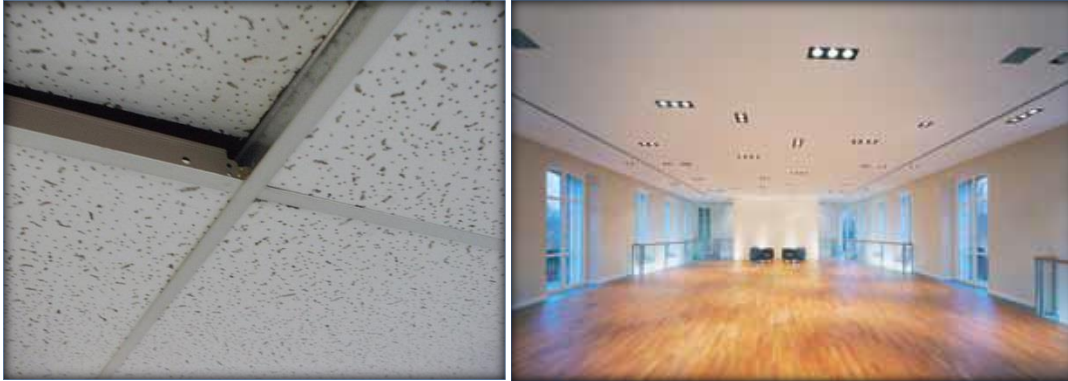
Figura 2.4 Cielo raso (derecha), cielo modular (izquierda)
