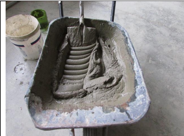
Consistencia mezcla suelo-cal
