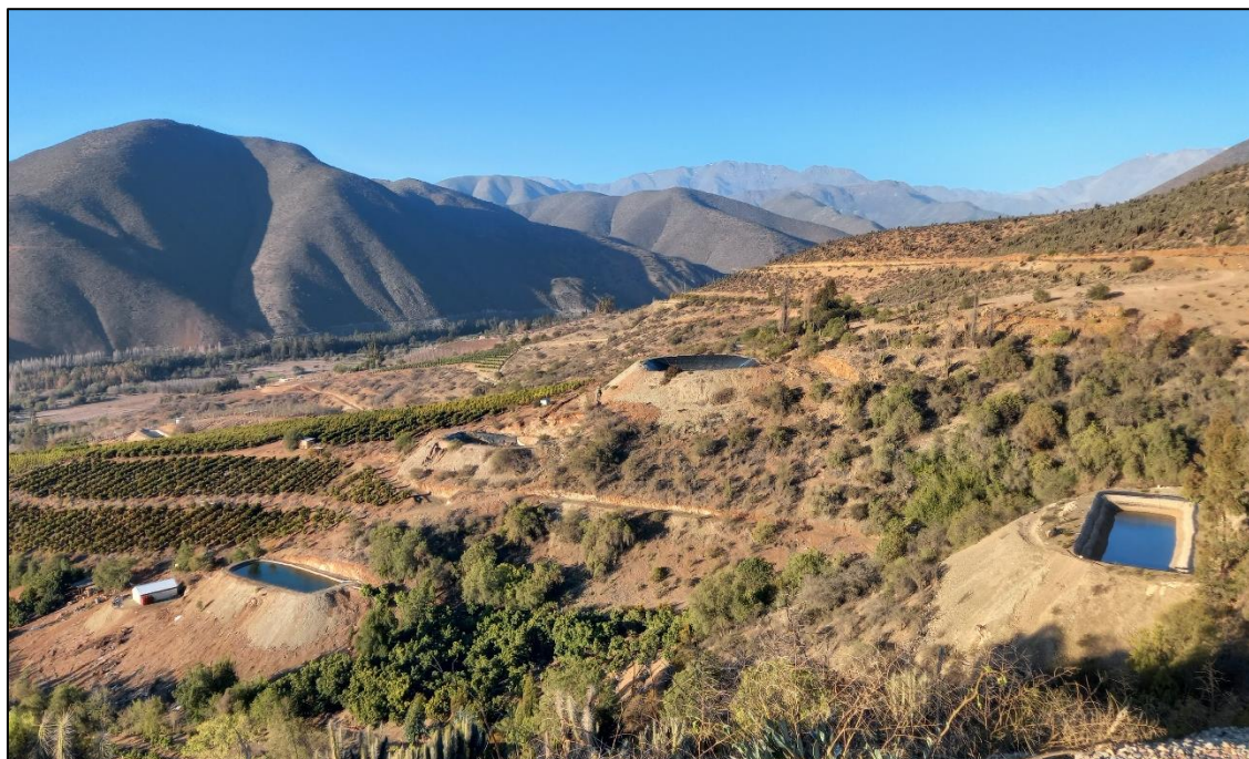
Figura 6.1: Tranques impermeabilizados con geomembrana en la subcuenca en estudio.
