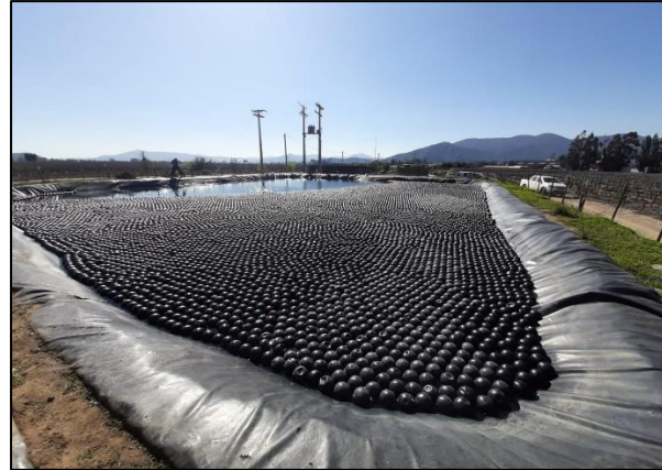
Figura 5.5: Esferas de polietileno flotando sobre tranque acumulador agrícola. Proyecto realizado en Viña Concha y Toro – Casablanca, por empresa Exma. (Fuente: https://www.barrierball.cl/proyectos_detalle28 )
