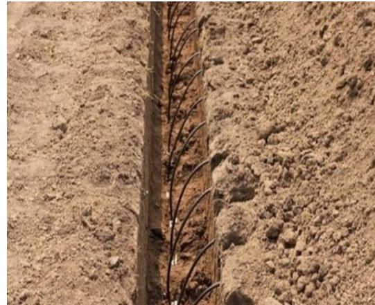
Figura 5.7: Instalación de un sistema de riego por goteo subterráneo. Fuente:
