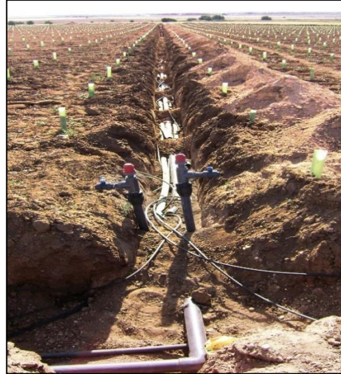
Figura 5.9: Sistema de riego subterráneo con adaptaciones para su utilización en fertirrigación.
