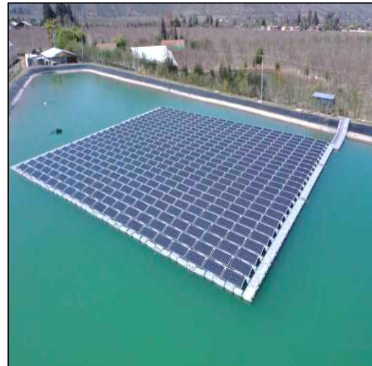
Figura 5.8: Planta solar flotante desarrollado por la empresa Solarity en la comuna de Putaendo, Chile.
