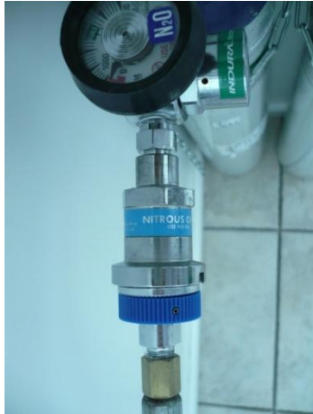
Figura III y IV: sistema de pines de ambos gases
