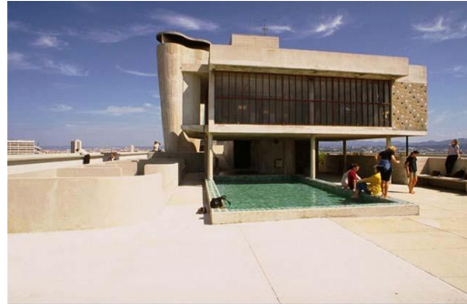
Nivel de terraza comunitaria con piscina
