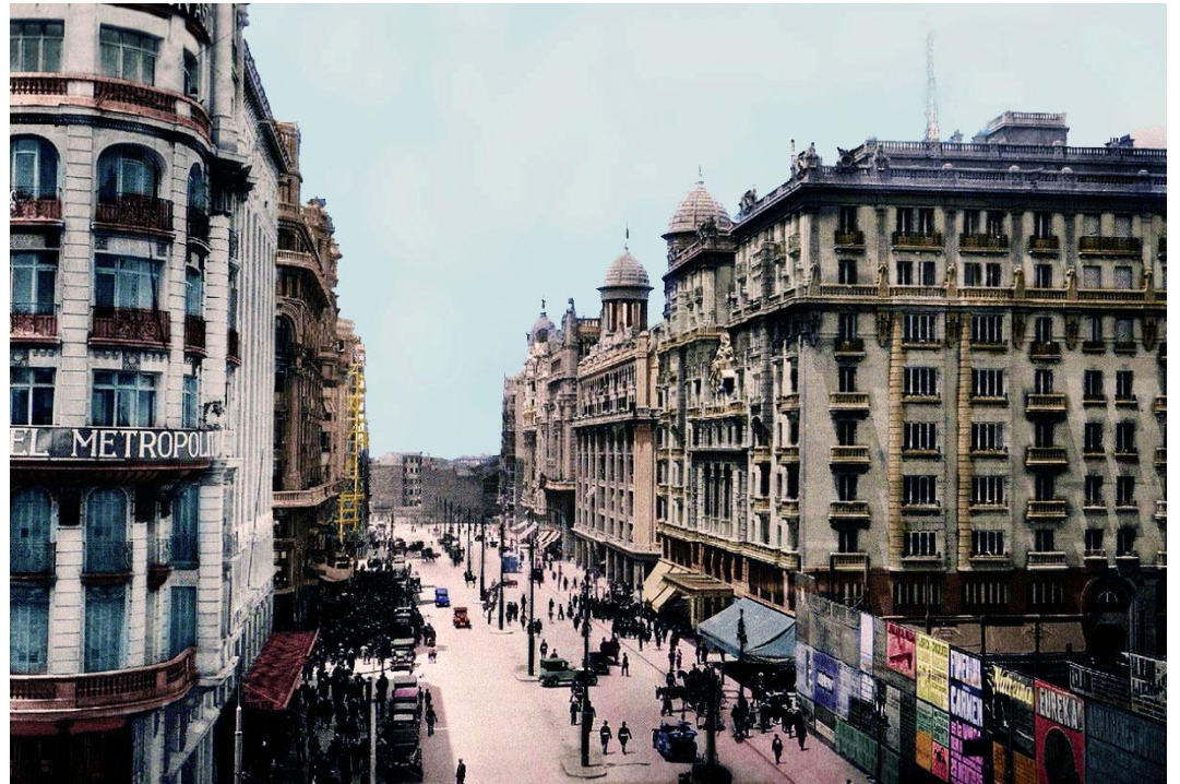
F18. Vista Gran Vía , Madrid, 1933 (12)
