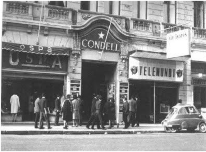
F31. Fachada de acceso a la galería desde Condell., Años 60. (21)
