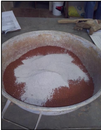
Suelo natural y cemento (13%) antes de homogenización
