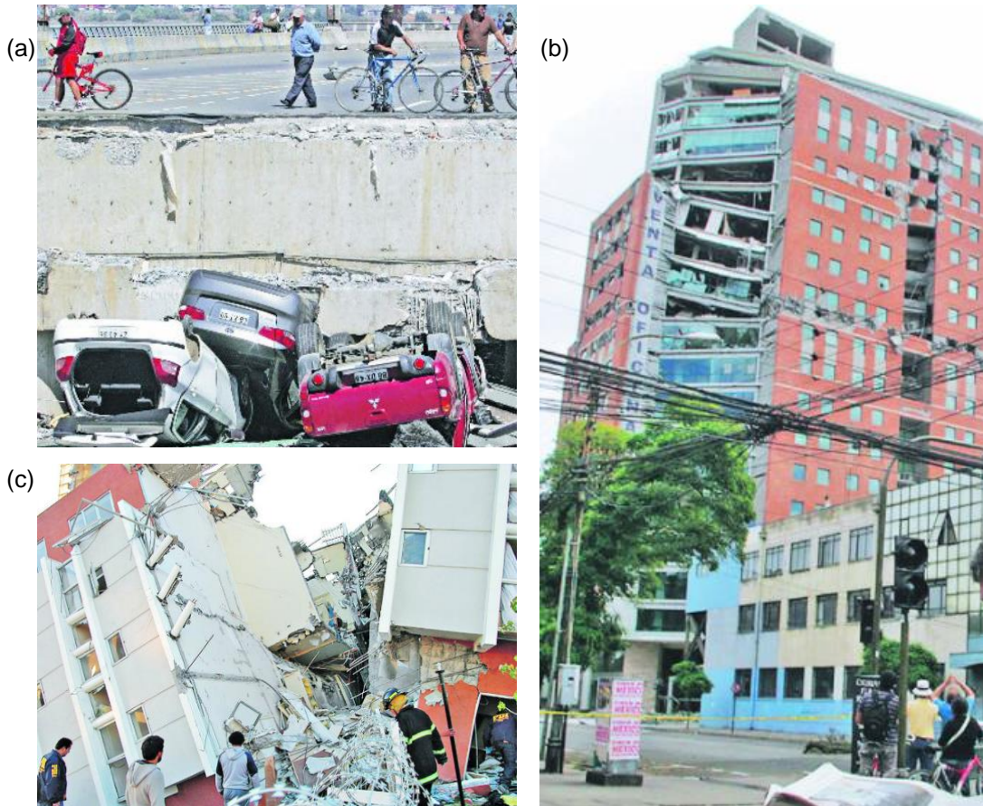
Figura 1.1 Infraestructura colapsada en Concepción posterior al Terremoto del 27 de Febrero de 2010: (a) Viaducto Chacabuco, (b) Torre O'Higgins, (c) Edificio Alto Río. [3]
