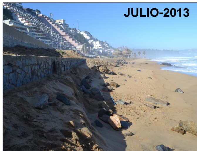
Figura 5. 1: Vista transversal de playa Reñaca, post-marejada. Fuente: Elaboración propia.
