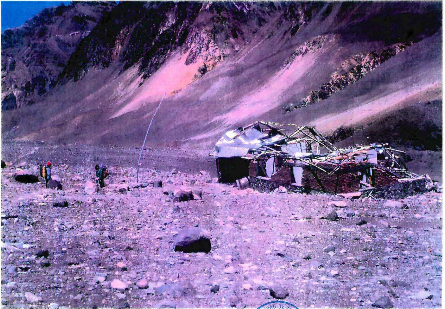
Refugio Ibañez destruído por una avalancha de nieve . Cerro Aconcagua, Argentina.
