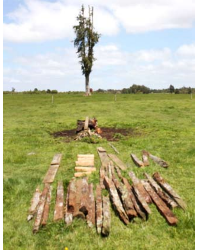
3. Disposición y reconocimiento de las maderas recicladas del lugar, para su reutilización en el proceso constructivo.
