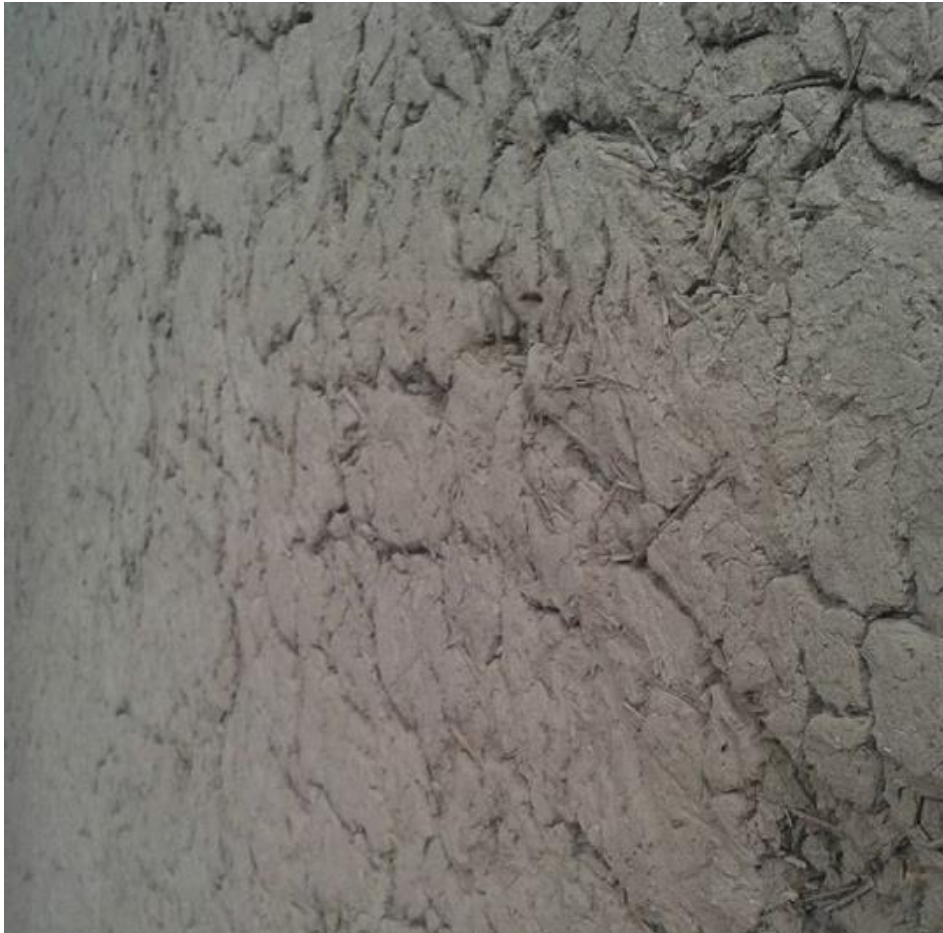
Fotografía muro de adobe Comuna Putaendo
