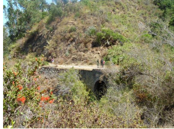
Bóveda de cañón corrido, camino hidro
