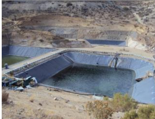
Figura 1.17: Piscina de drenes Tranque Quillayes, Dirección General de Aguas, 2015.
