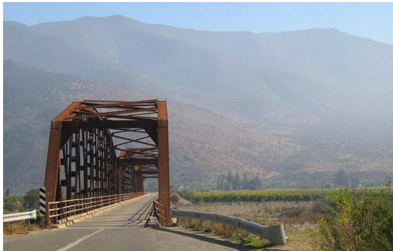
IMAGEN °5 Puente Pedegua
