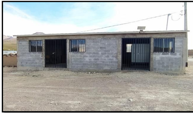
Figura n°24. Sede donde se Ubica el Generador de Energía (Fuente: Propia, 2020).
