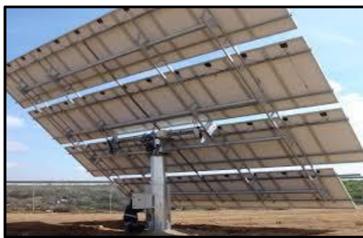
Figura n°11. Estructura con Seguimiento (Fuente: Eficiencia Energetica y Utopia, 2015).
