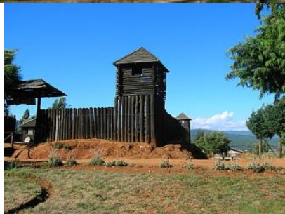
Entrada trasera al fuerte desde la cima del cerro.
