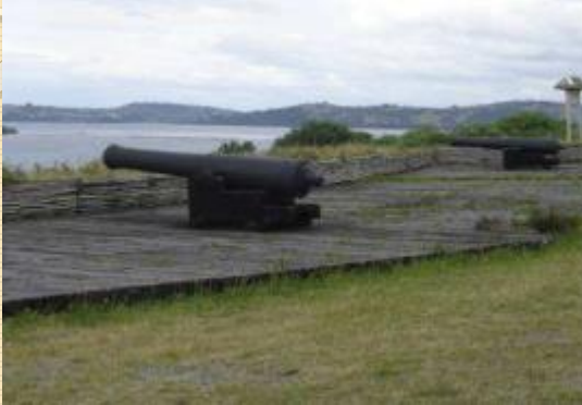
Explanada de madera restaurada del fortín Tauco. Comuna de Chonchi.
