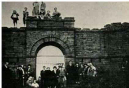
Entrada principal del Fuerte Ahüi, con su imponente arco y columnas laterales, hacia 1935. Memorias del siglo XX.2010
