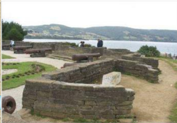
Tronera de la Batería.
