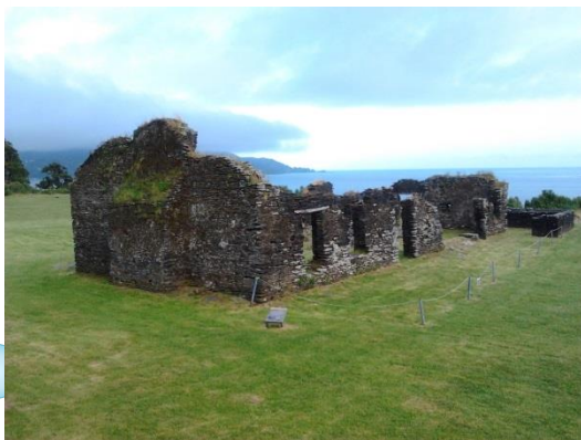
Dentro del fuerte se encuentran edificios en ruinas con una breve reseña. Acción museológica.
