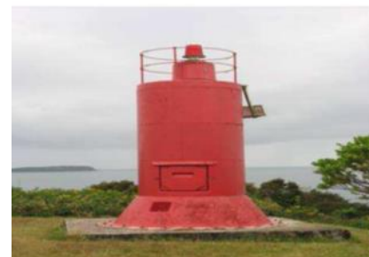
Faro a batería de Fuerte Agüi, sirve para guiar la embarcaciones en el canal de chacao.
