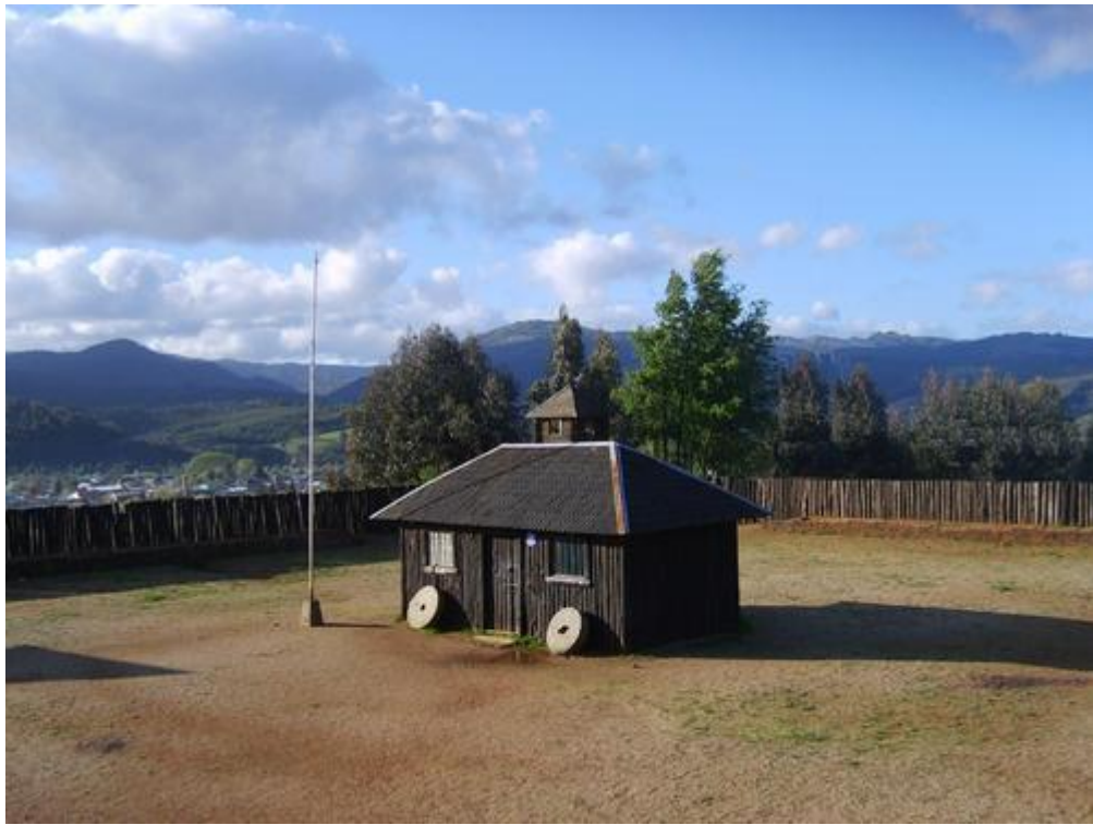
Interior del fuerte. Un pequeño edificio en el centro. Vista hacia la relación con la ciudad y el territorio.
